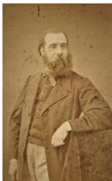
Une des premières photos du romancier, non datée.
